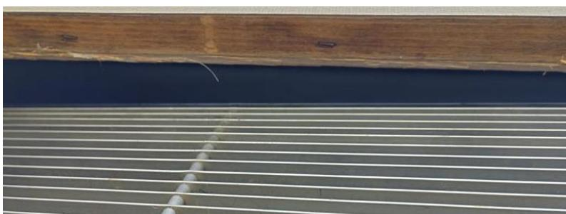
Das freiliegende Vor-/Rücklauf Rohrsystem unterliegt durch ständige Bewegungen Spannungen, welche zu Ermüdungsbrüchen und/oder Leckagen führen können. Das kann wiederum zu folgeschweren Schäden wie Wasserschäden oder gar Ausfall der Raumheizung führen. Die Einstellventile arbeiten nicht mehr präzise, so dass eine Steuerung der Raumtemperatur über die Thermostaten schwierig ist und zu hohem Energieverbrauch führt.
