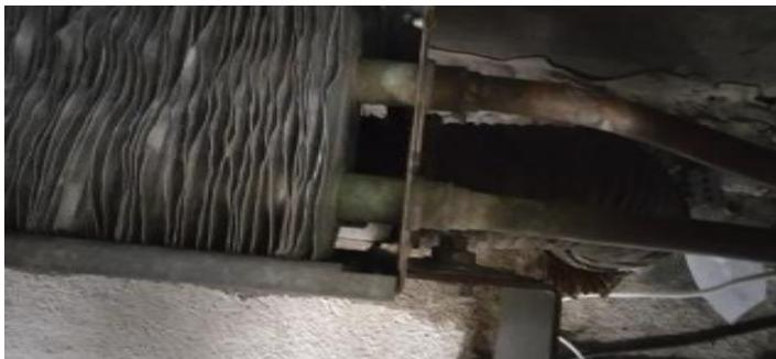
Im Laufe der Jahre wurden ständig neue Kabel- und Daten-Leitungsinstallationen in die Brüstung verbaut. Dabei wurden alte, nicht mehr benötigte, Leitungen nie entfernt. Dies trägt dazu bei, dass Interventionen an den Leitungen und den Heizungs-/Lüftungsinstallationen erschwert werden.
